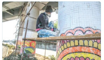
زیباسازی پایه‌های پل‌های سطح شهر با هنر کاشی شکسته
